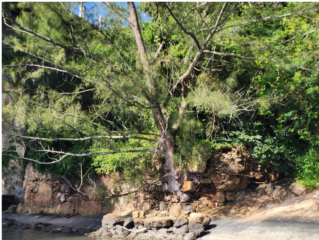
Figura 1: Registro próprio realizado no Canal do Bacalhau de partes das ruínas da antiga Casa do Porto.
