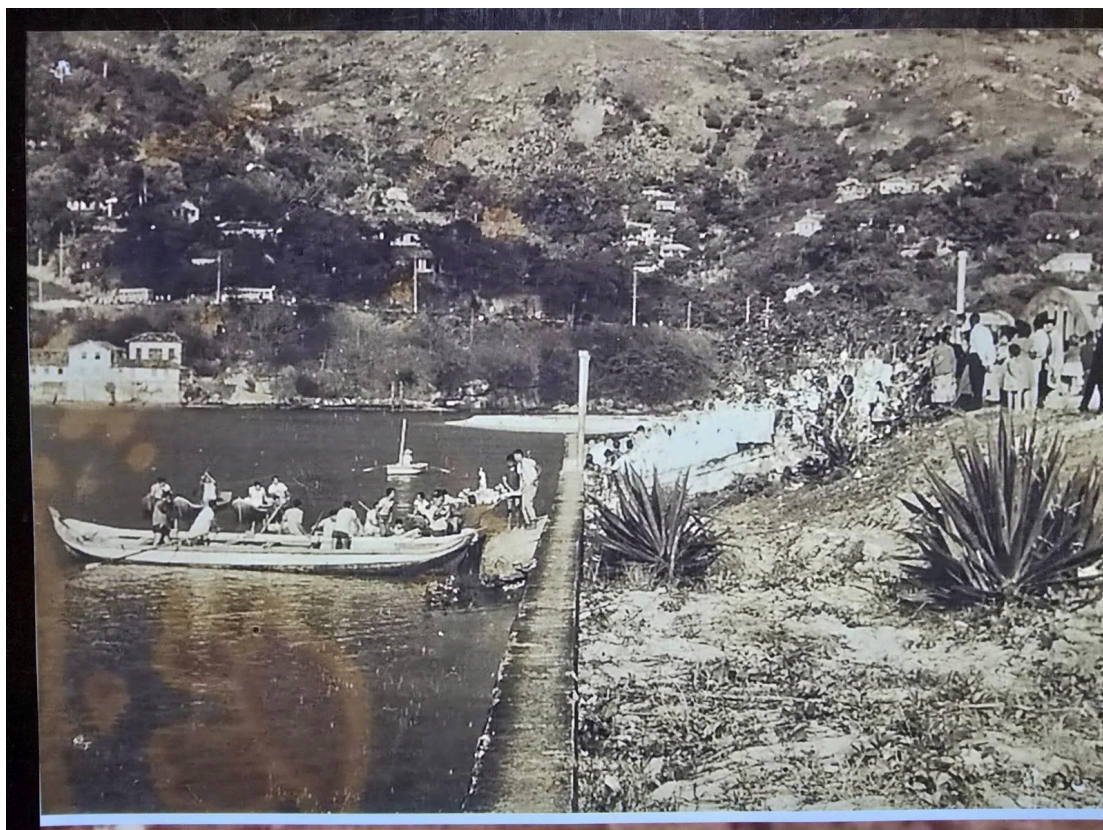
Figura 3: Trabalhadores desembarcam na Marambaia para a construção da ponte, ao fundo se vê a Casa do Porto.
