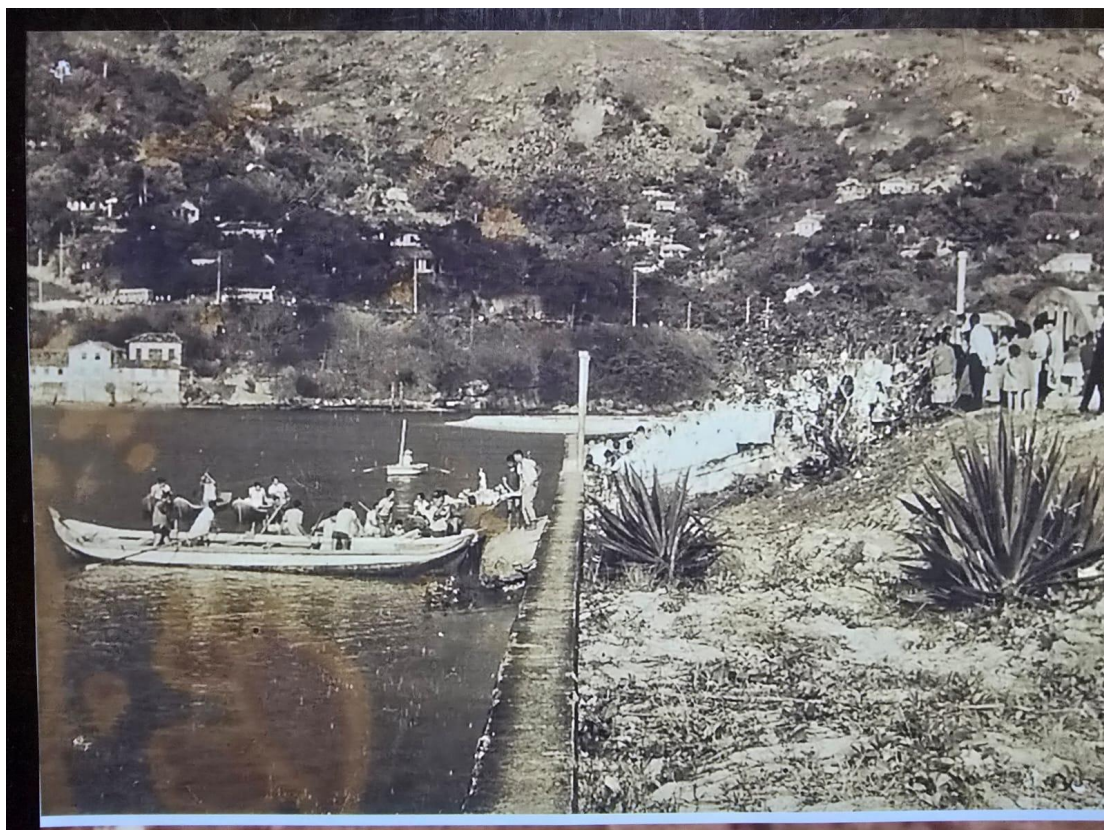
Figura 3: Trabajadores desembarcan en Marambaia para la construcción del puente; al fondo se ve la Casa del Puerto.
