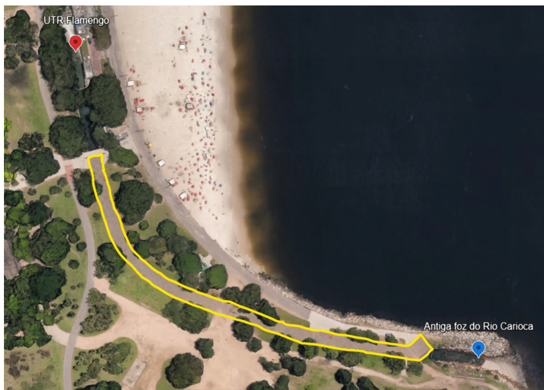
Figura 13: Deque de madeira representado pela área amarela, onde há o despejo ilegal de esgoto.
