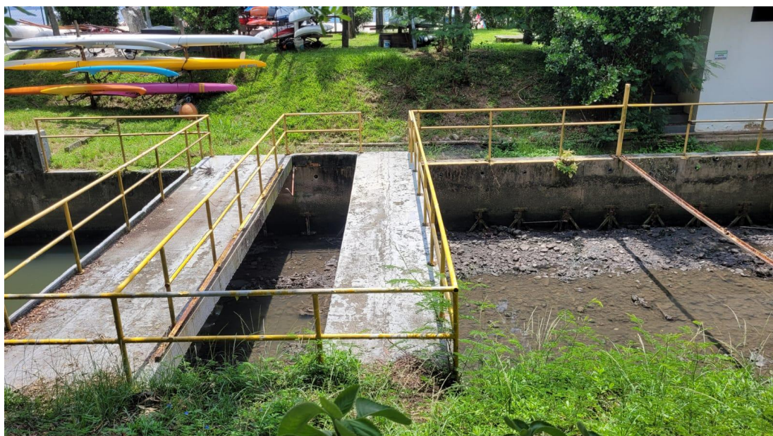
Figura 11 e 12: Fotografias da UTR Flamengo desativada.
