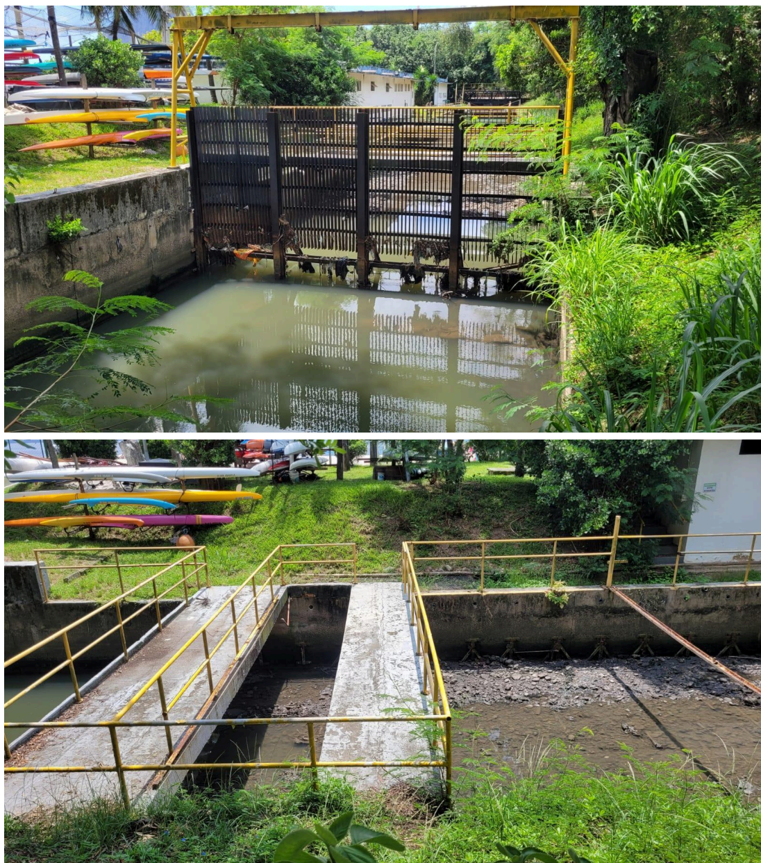
Figura 11 y 12: Fotografías de la UTR Flamengo desactivada.
