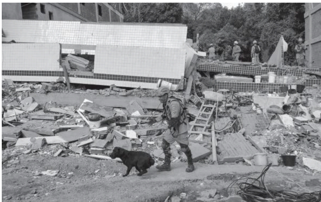
Figura 1: Desabamento de dois edifícios construídos irregularmente no bairro da Muzema.
