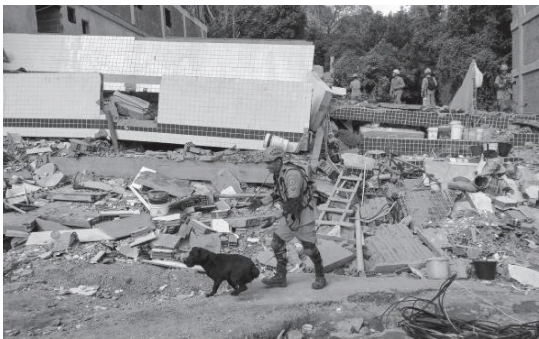
Figura 1: Colapso de dos edificios construidos de forma irregular en el barrio de Muzema.
