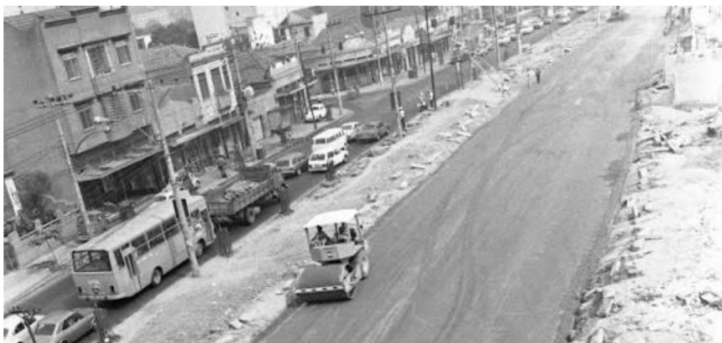
Figura 5: Registro de las obras de duplicación de la Av Suburbana, en 1980. Fuente: Memorias del Suburbio Carioca. Acervo O Globo. 2016
